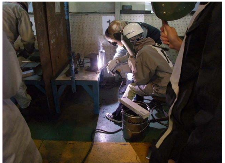
アーク溶接(立て向き)
