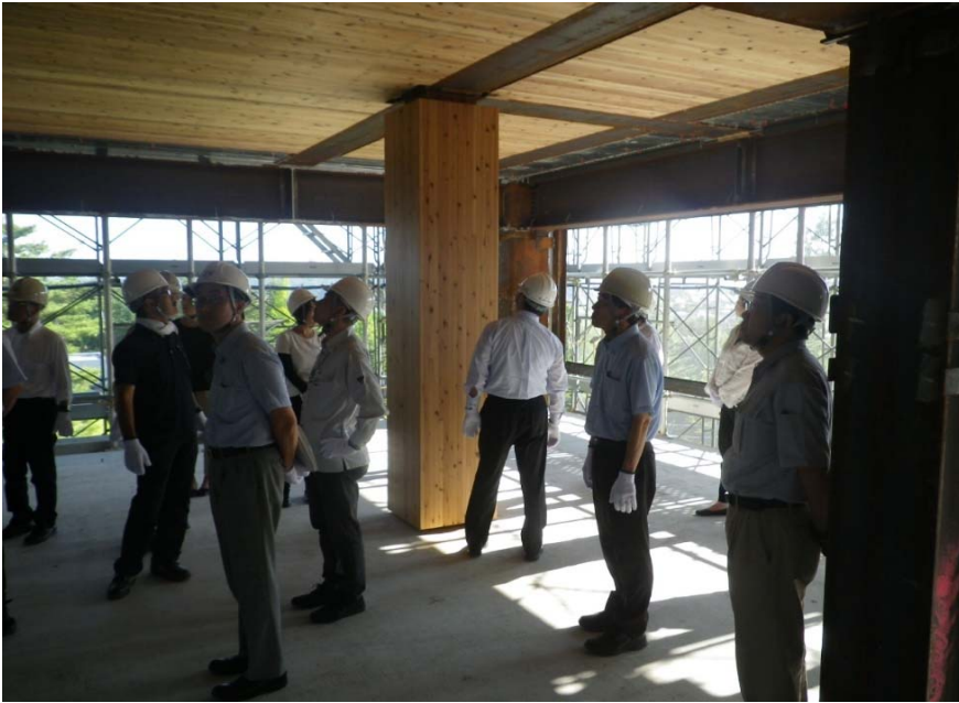
住戸内に現れる耐火集成材柱
