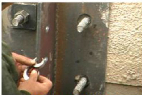
▶ジャストリング設置状況 施工前 (クリックで拡大)
