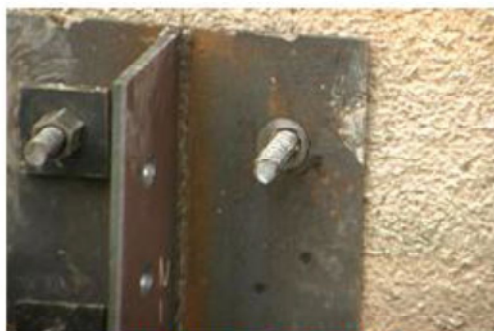
▶ジャストリング設置状況 施工後 (クリックで拡大)
