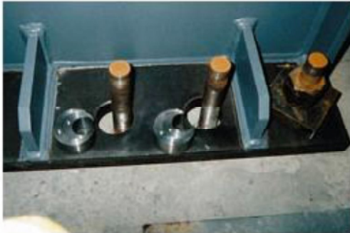
▶アンカーボルト位置の状況(クリックで拡大)
