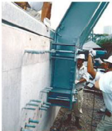
▶ボルト締め付け状況 (クリックで拡大)
