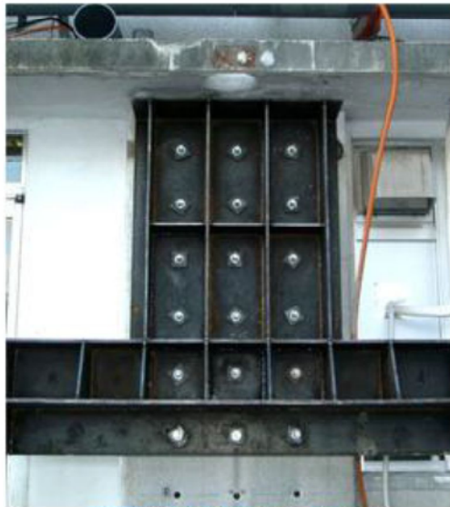
▶基礎補強壁設置完了(クリックで拡大)
