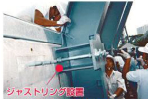
▶遮音壁設置状況(クリックで拡大)
