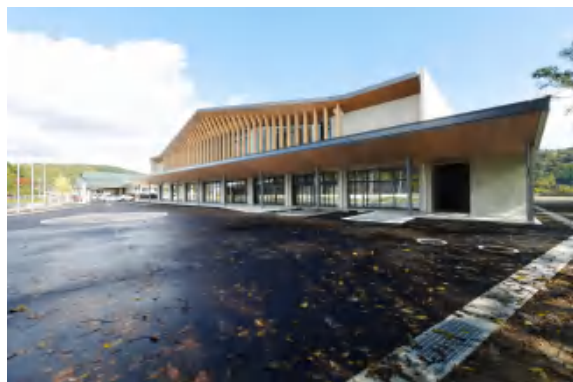
仙北市役所角館庁舎（秋田県）
